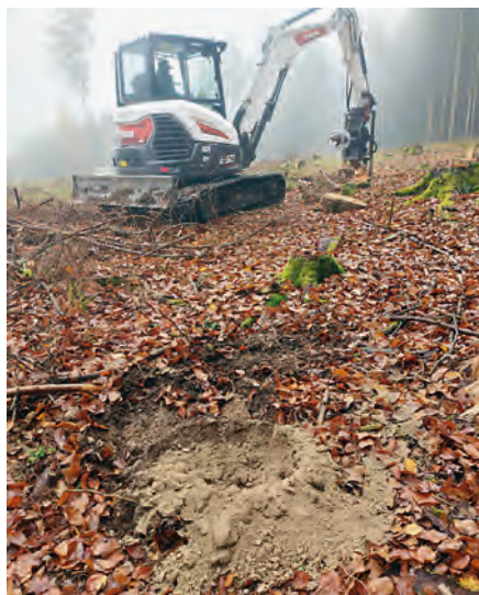
Fertig gekrümeltes Pflanzloch.
